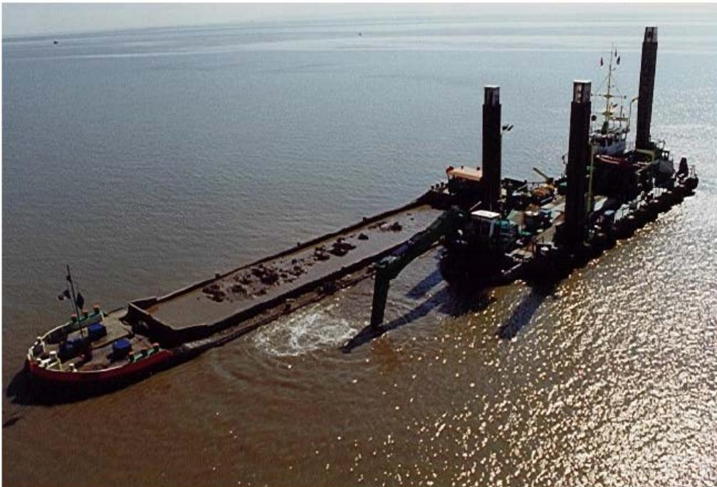
**Figure 88 : Excavation mécanique et stockage provisoire sur chaland des matériaux**
