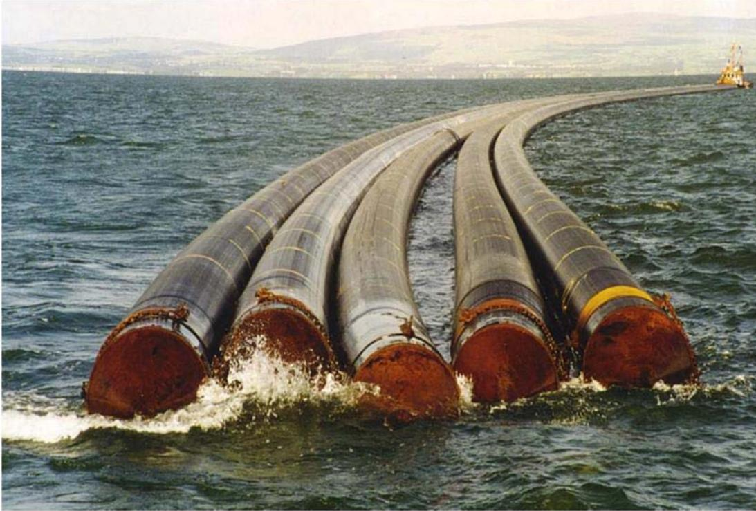
**Figure 72 : Mode de remorquage des conduites sous marines du fournisseur vers le site de chantier**
