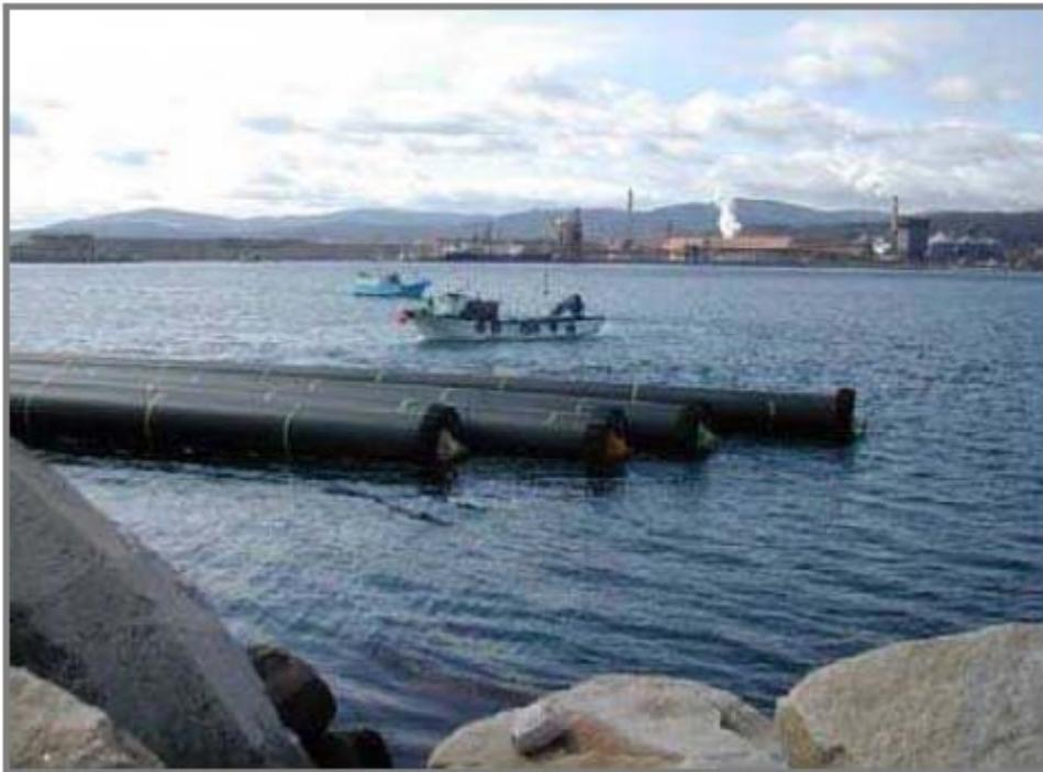
**Figure 73 : Mode de stockage des conduites dans une zone abritée**
